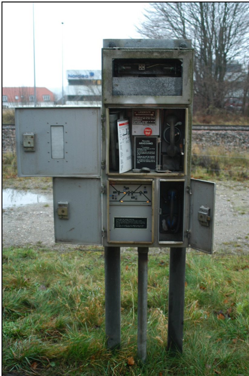
Betjeningskab type DSB 1953, 1953/54, 1954, 1972, åbent
