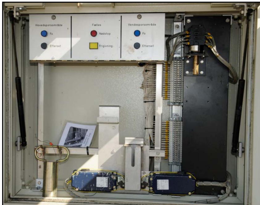
Skab med nødpanel type DSB 1990
