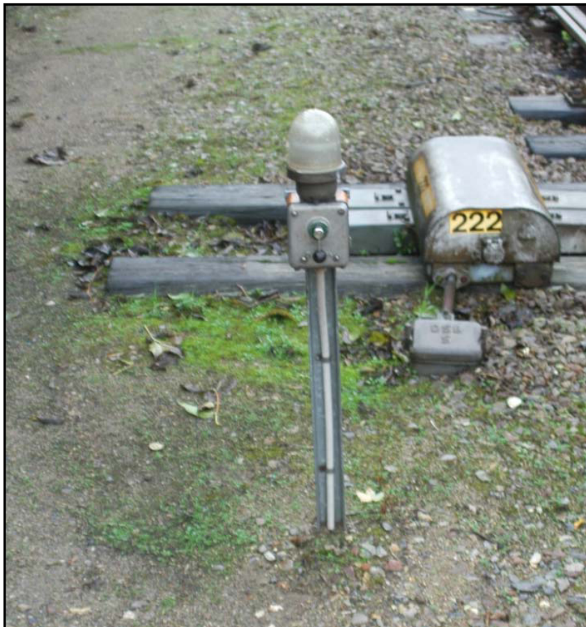
Centralaflåst sporskifte med el-stedbetjening
