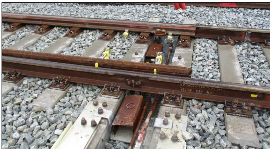
Billedet viser placering af låsebolte.
