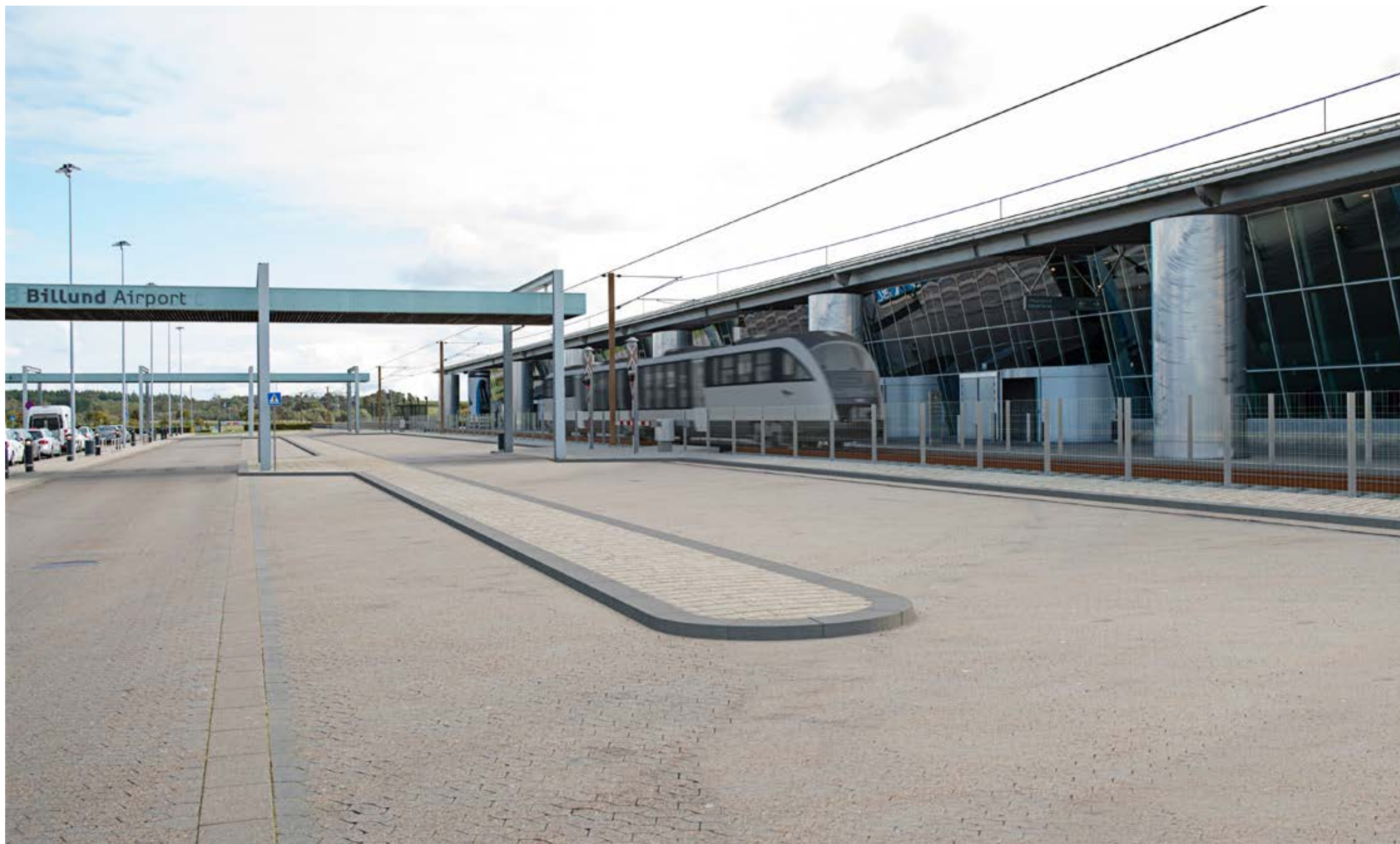
Fotostandpunkt 27 ved Billund Lufthavn Passagerterminalen vest, fremtidige forhold. Billedet er optaget med en 35 mm optik Betragtningsafstand 40 cm.
