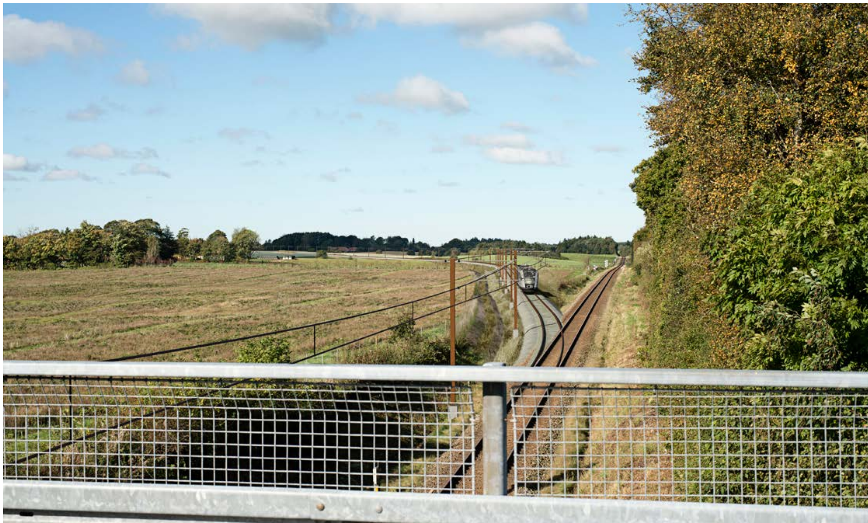
Fotostandpunkt 16 ved Allévej, fremtidige forhold. Billedet er optaget med en 50 mm optik Betragtningsafstand 58 cm.
