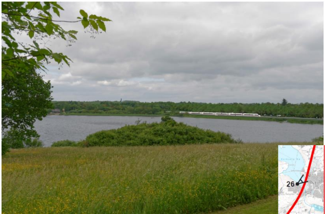
Figur 45. Visualisering af Central linjeføring igennem Solbjerg forbi den østlige del af Stilling-Solbjerg Sø. Her set fra et bynært, rekreativt område langs søens sydlige bred. Perronen til en station i Solbjerg indgår i visualiseringen, mens de øvrige anlæg omkring stationen ligger uden for det illustrerede synsfelt.
