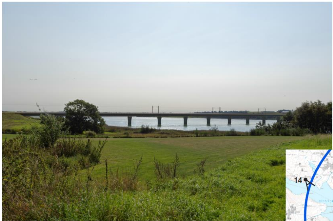
Figur 5. Visualisering af Vestlig linjeføring over Stilling-Solbjerg Sø set mod sydøst fra Søvejen vest for linjeføringen.
