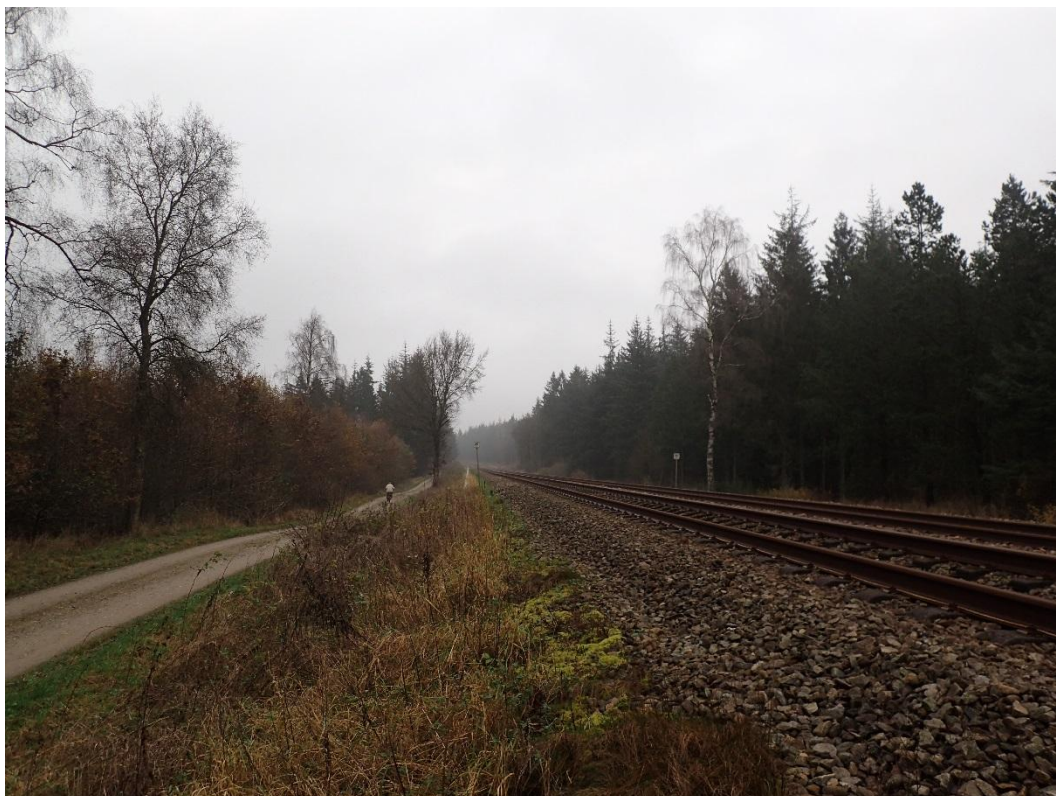
Figur 8 Den eksisterende bane gennem Rold Skov i km 217+400, hvor skovvejen ses til venstre i billedet.
